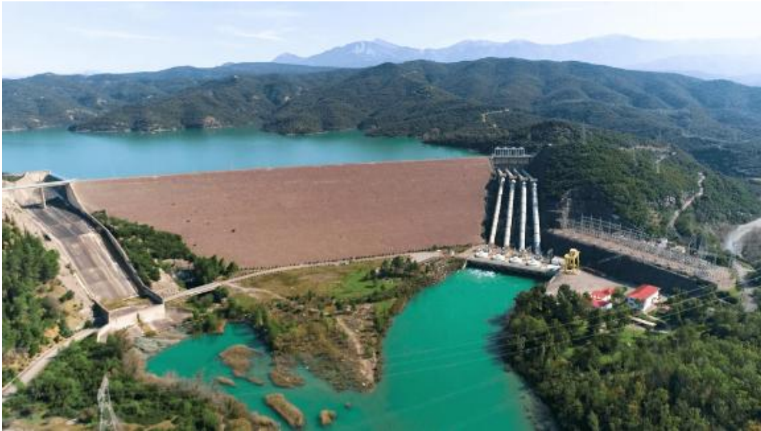
Ταμιευτήρας Καστρακίου, Σύστημα Ταμιευτήρων Αχελώου
